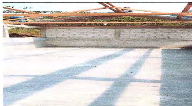
Foto 4: Se nivela con concreto y alizado dentro del aula.
