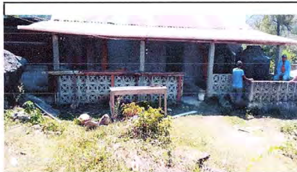
Foto 2: Colocación de solera de celocilla de la cocina.
