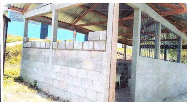
Foto 5: Colocación de block de una aula.
