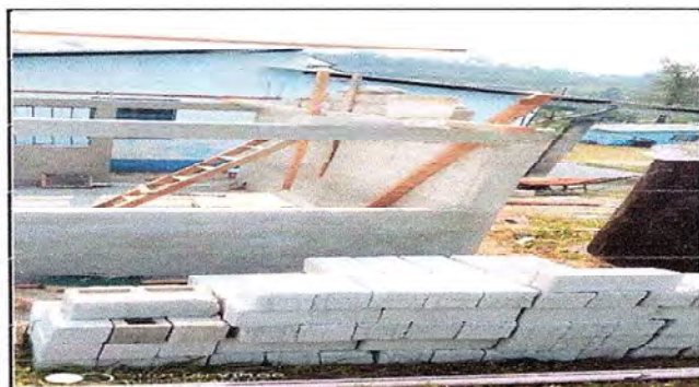
Foto 3: Sustitución de mojineta.
